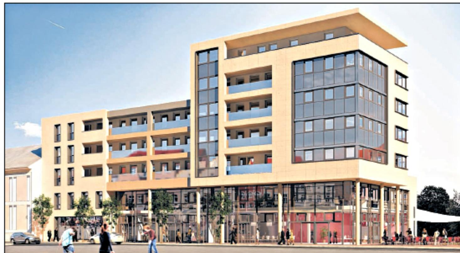
**Die hochwertige, vorgehängte und hinterlüftete Fassade aus Aluverbundplatten (Alucobond) von Haus 1 des Postareals ist ein Blickfang.**
